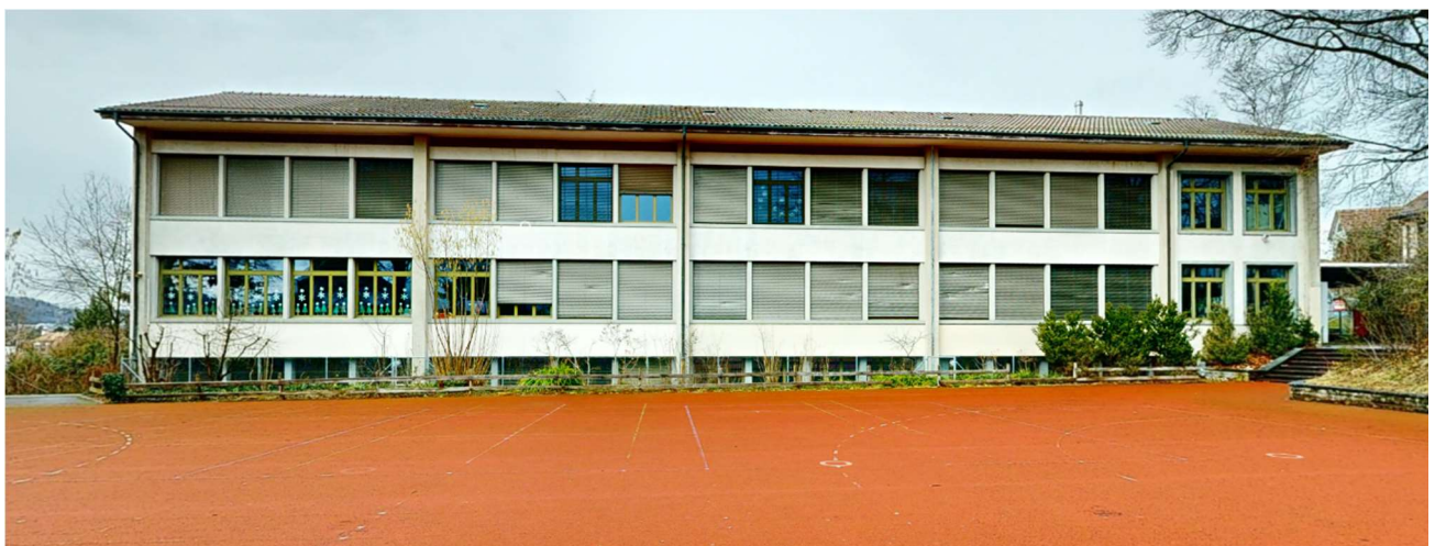
Abbildung 27 Turnhallentrakt Fassade NW
