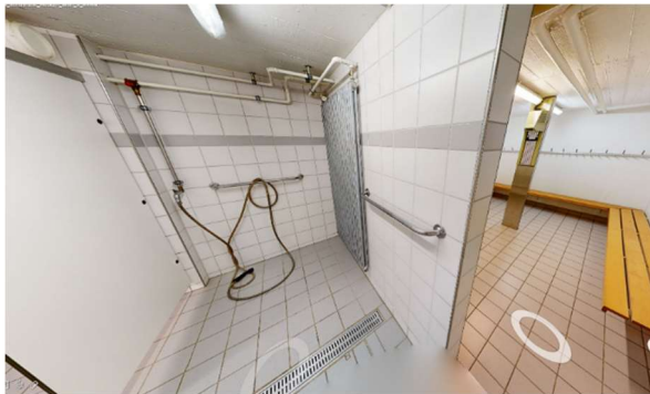
Abbildung 39 Garderobe Duschanlage UG
