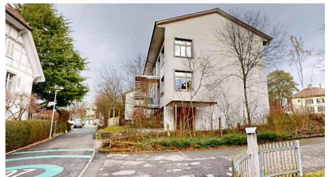
Abbildung 26 Klassentrakt Stirnfassade Südwest
