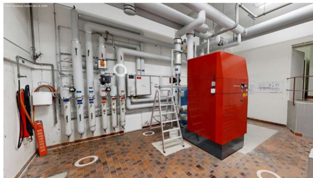
Abbildung 42 Heizungsraum / Fernwärmeerzeugung
