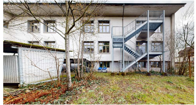
Abbildung 24 Klassentrakt Fassade Nordost
