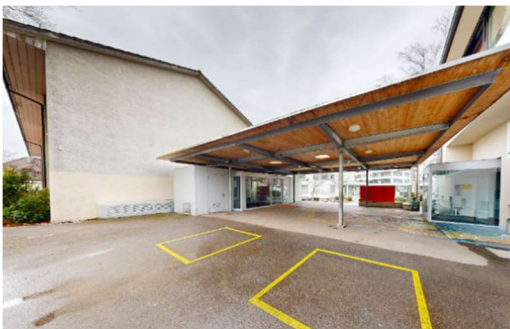
Abbildung 32 Eingangssituation Blick- richtung West
