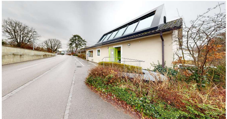
Abbildung 29 Turnhallentrakt Ecke Nord
