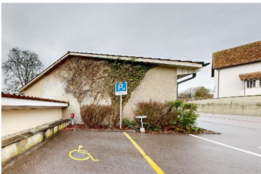
Abbildung 30 Stirnfassade Turnhalle - inkl. Kunst am Bau
