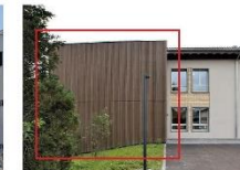
Schulanlage Steermatt, Lussy; plastische Abhebung
