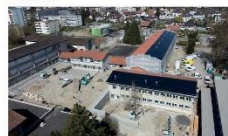
Schulanlage Stepmatt, Löss/Indach-Anlage nach 1. Bauetappe
